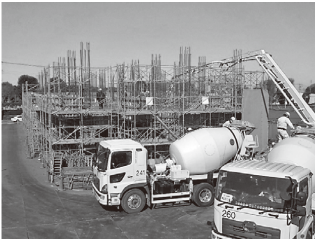
令和5年2月16日 南西から撮影
