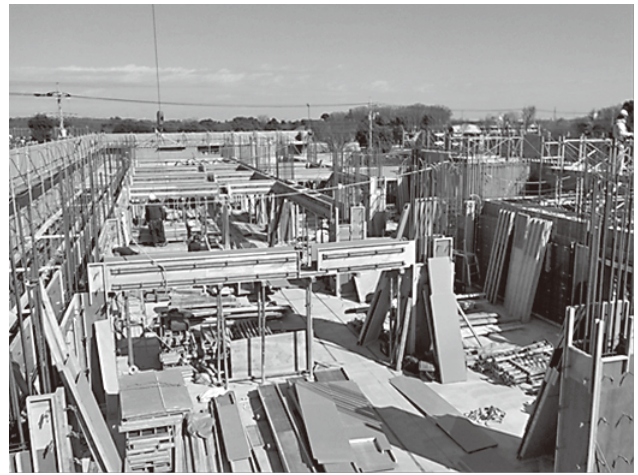
令和5年3月2日 南西から3階撮影
